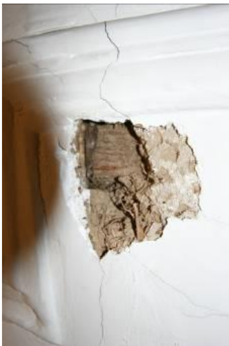
voorbeelden van aangetroffen beschadigingen aan de leemstucplafonds
