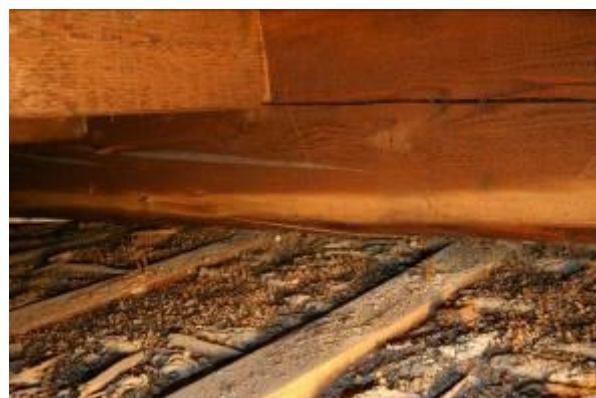
links: de eiken latjes zijn met ijzeren nagels op de moer- en kinderbinten vastgezet rechts: op het leemstucplafond zijn bloemblaadjes/vliesjes aangetroffen in een dunne laag over het hele oppervlak
