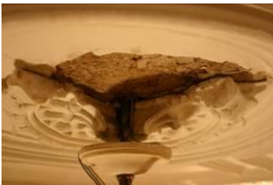
middenornament in halplafond dat van later datum is en uit gietstukken (gips) bestaat
