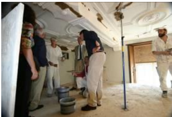
links: inspectie tijdens uitvoering rechts: ondersteuning van plafonddelen tijdens de consolidatiewerkzaamheden
