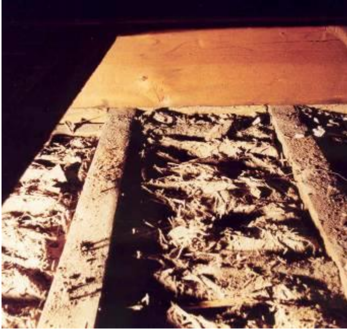
links: bovenzijde stucplafond met leemruggen rechts: kalverharen die in de mortel worden verwerkt
