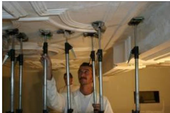
links: inspectie tijdens uitvoering rechts: ondersteuning van plafonddelen tijdens de consolidatiewerkzaamheden
