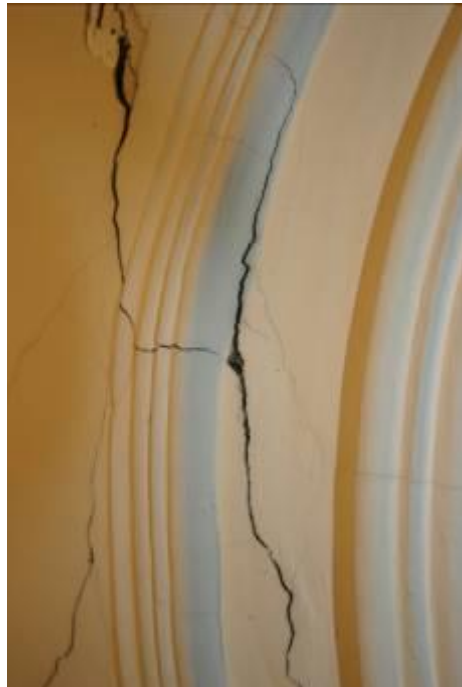
voorbeelden van aangetroffen beschadigingen aan de leemstucplafonds
