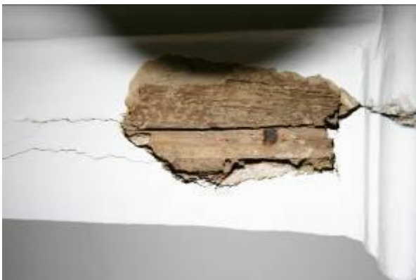
links: de eiken latjes zijn met ijzeren nagels op de moer- en kinderbinten vastgezet rechts: op het leemstucplafond zijn bloemblaadjes/vliesjes aangetroffen in een dunne laag over het hele oppervlak
