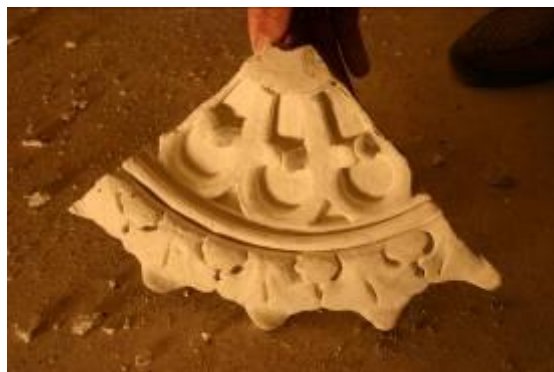
middenornament in halplafond dat van later datum is en uit gietstukken (gips) bestaat
